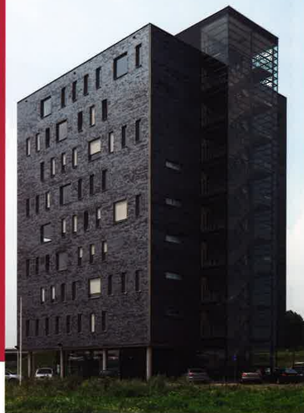
Kantoortoren De Poort van Veghel, Veghel (Arceau Architecten) Foto Pierre Crom
